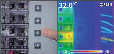
Eine fehlerhafte Verbindung wird mit dem bloßen Auge nicht erkannt, aber im Wärmebild klar angezeigt.
