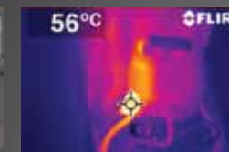
Das sieht eine Wärmebildkamera.
