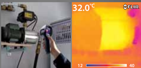
Die Thermografie macht elektrische und mechanische Probleme sofort sichtbar.
